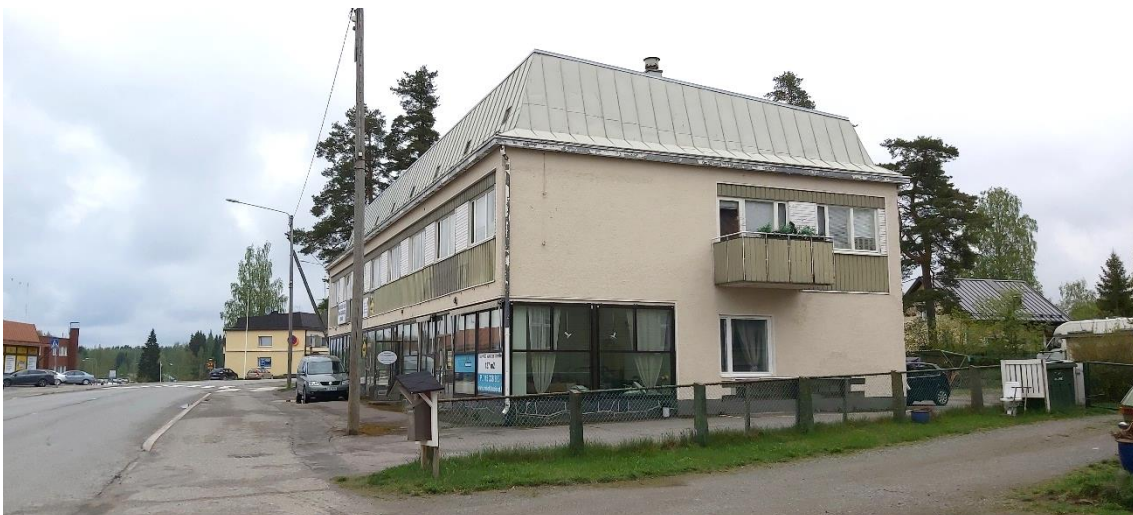
Kuva 12 Rakennuksen eteläinen julkisivu, jossa parveke.
