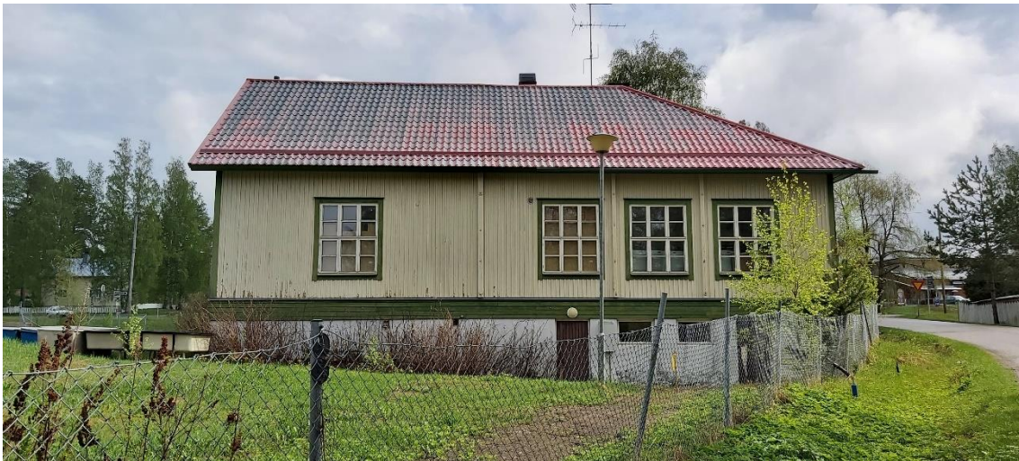
Kuva 34 Entisen kansakoulun ja nuorisotalon julkisivu länteen.
