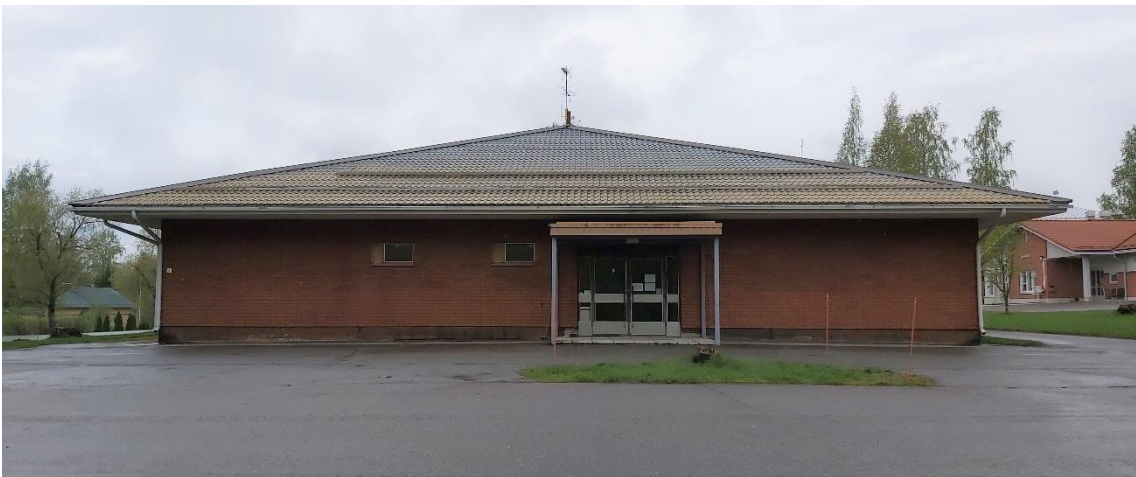
Kuva 49 Entisen terveysaseman julkisivu etelään, jossa sijaitsee rakennuksen pääsisäänkäynti.
