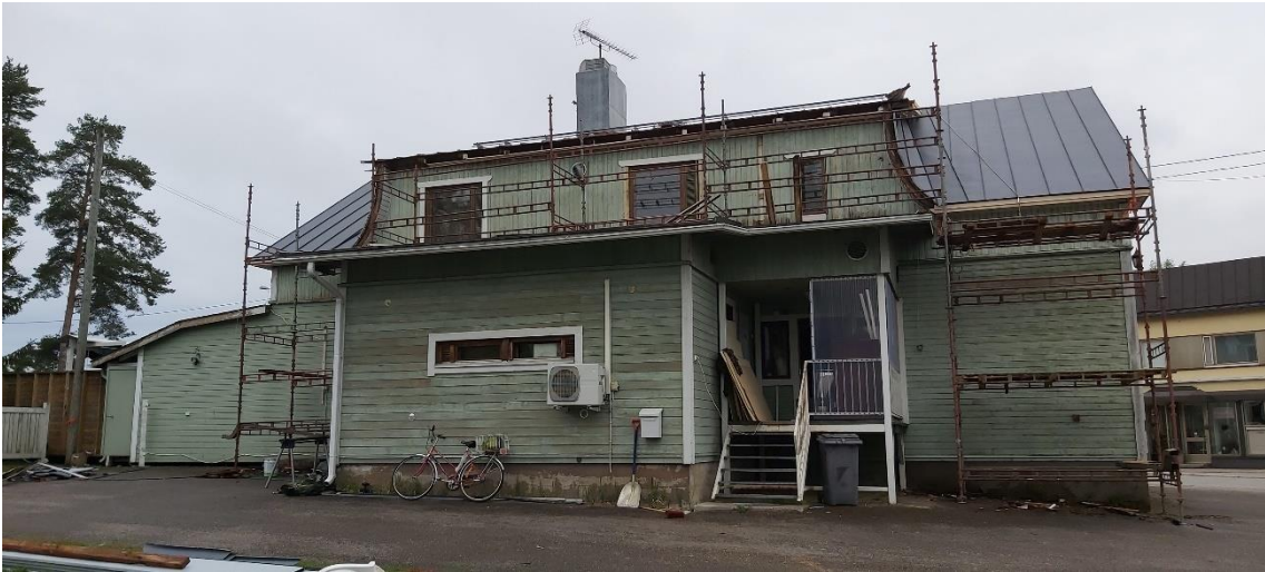
Kuva 55 Rakennuksen julkisivu itään sisäpihan suuntaan. Myös rakennuksen kattoa kunnostetaan kuvien ottamishetkellä.
