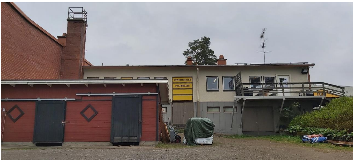
Kuva 64 Wanha Osula -rakennuksen eteläisen siiven julkisivua länteen sisäpihan ja Pieksämäentien suuntaan.
