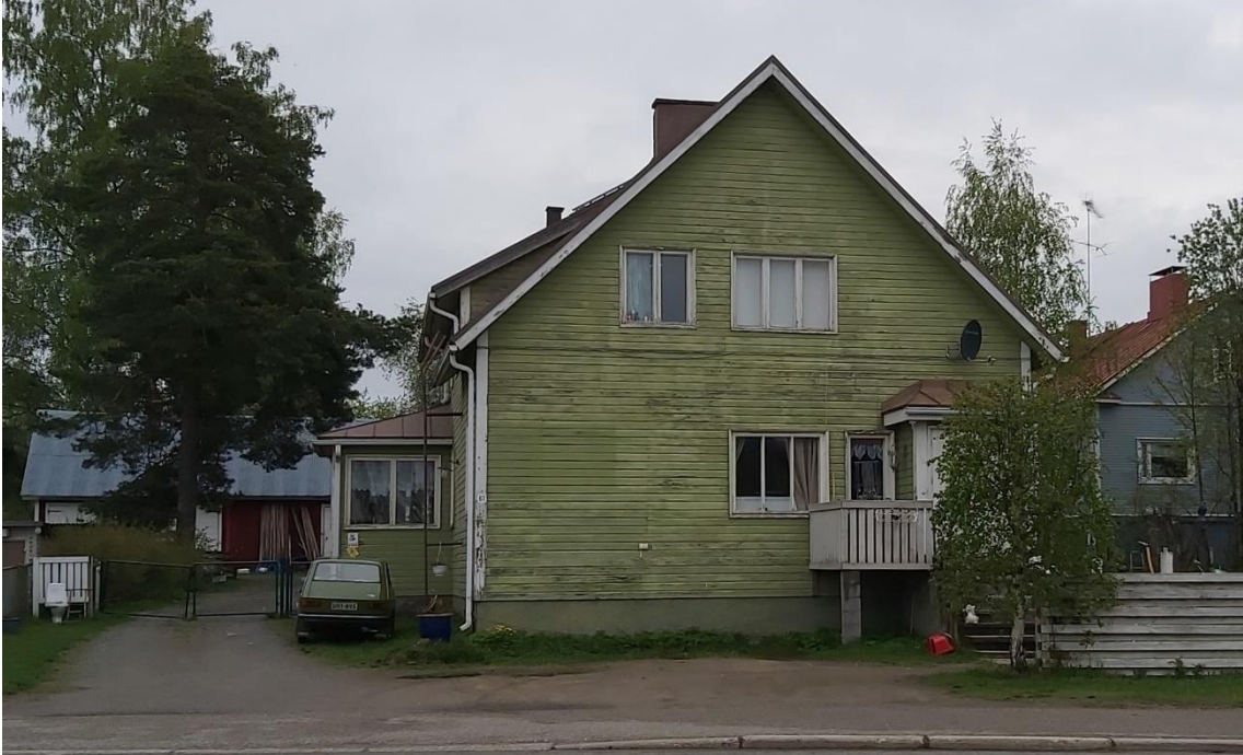
Kuva 81 Entisen osuuskassan itäinen julkisivu Keskustien suuntaan.
