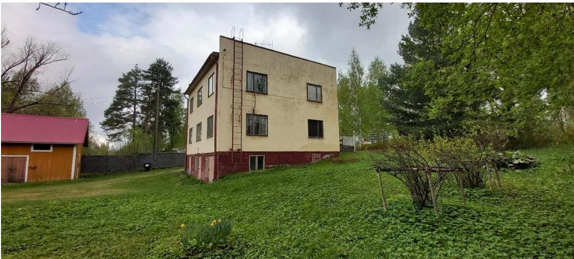
Kuva 21 Keskustie 56:n julkisivu etelään pihan suuntaan.
