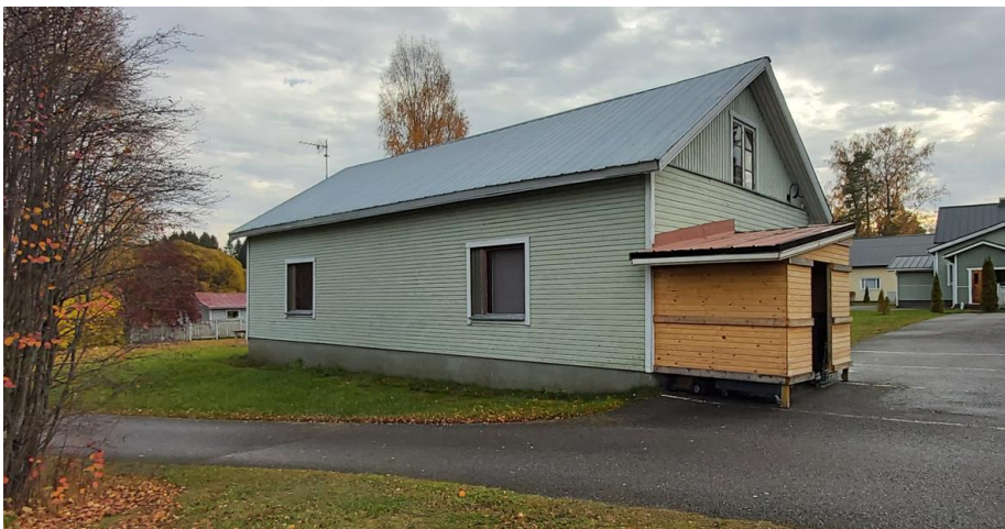
Kuva 58 Talousrakennuksen julkisivua pohjoiseen ja länteen.
