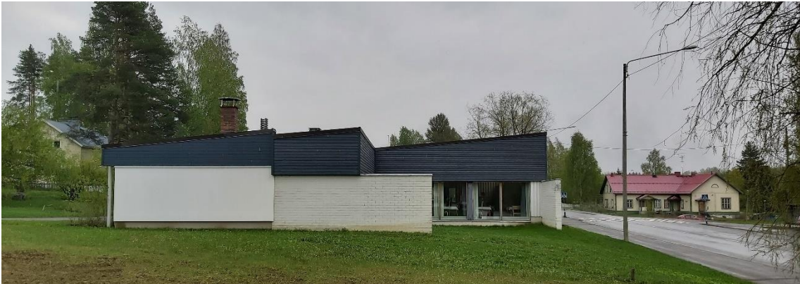
Kuva 25 Seurakuntatalon julkisivu pohjoiseen Haukivuoren torin suuntaan.
