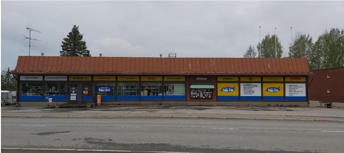
Kuva 61 Wanhan Osulan pääjulkisivu itään Keskustien suuntaan.
