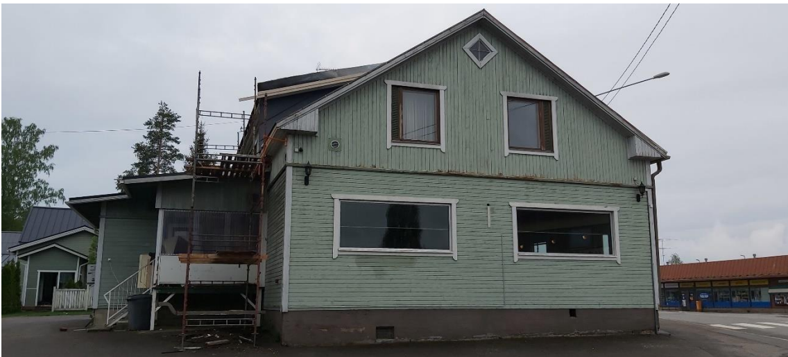
Kuva 54 Rakennuksen päätyjulkisivua pohjoiseen Haukivuorentien suuntaan.
