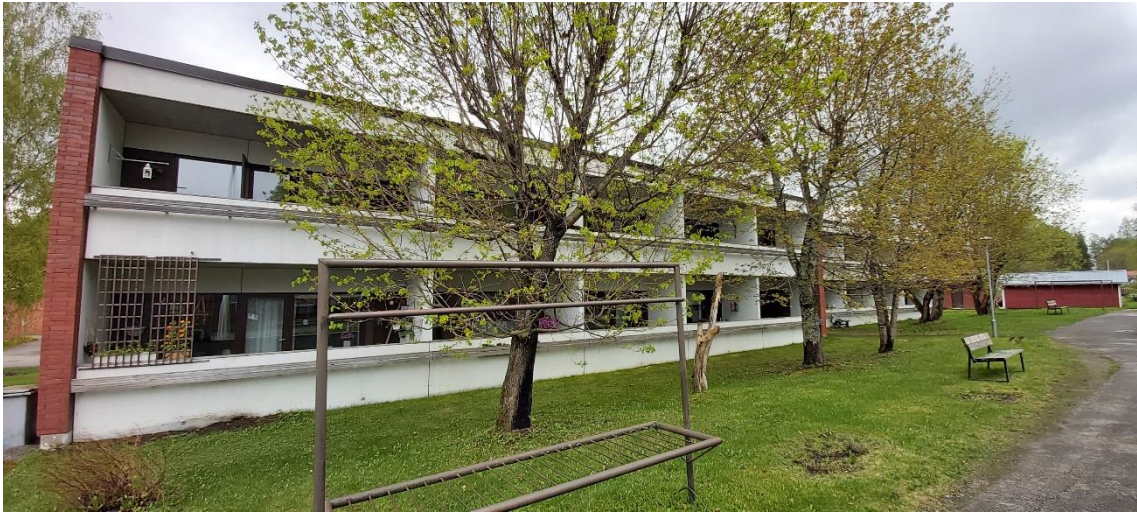
Kuva 88 Rakennuksen läntinen julkisivu, jossa sijaitsevat asuntokohtaiset parvekkeet.
