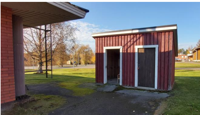
Kuva 50 Kiinteistöllä sijaitseva jätekatos.
